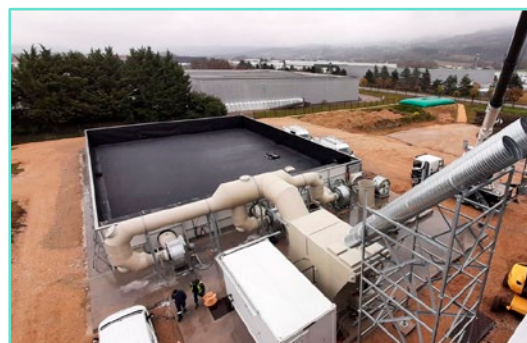
Installation en cours du biofiltre
